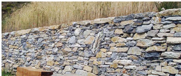
Stützmauer im Wallis. (Fotos: E. Bardill)
