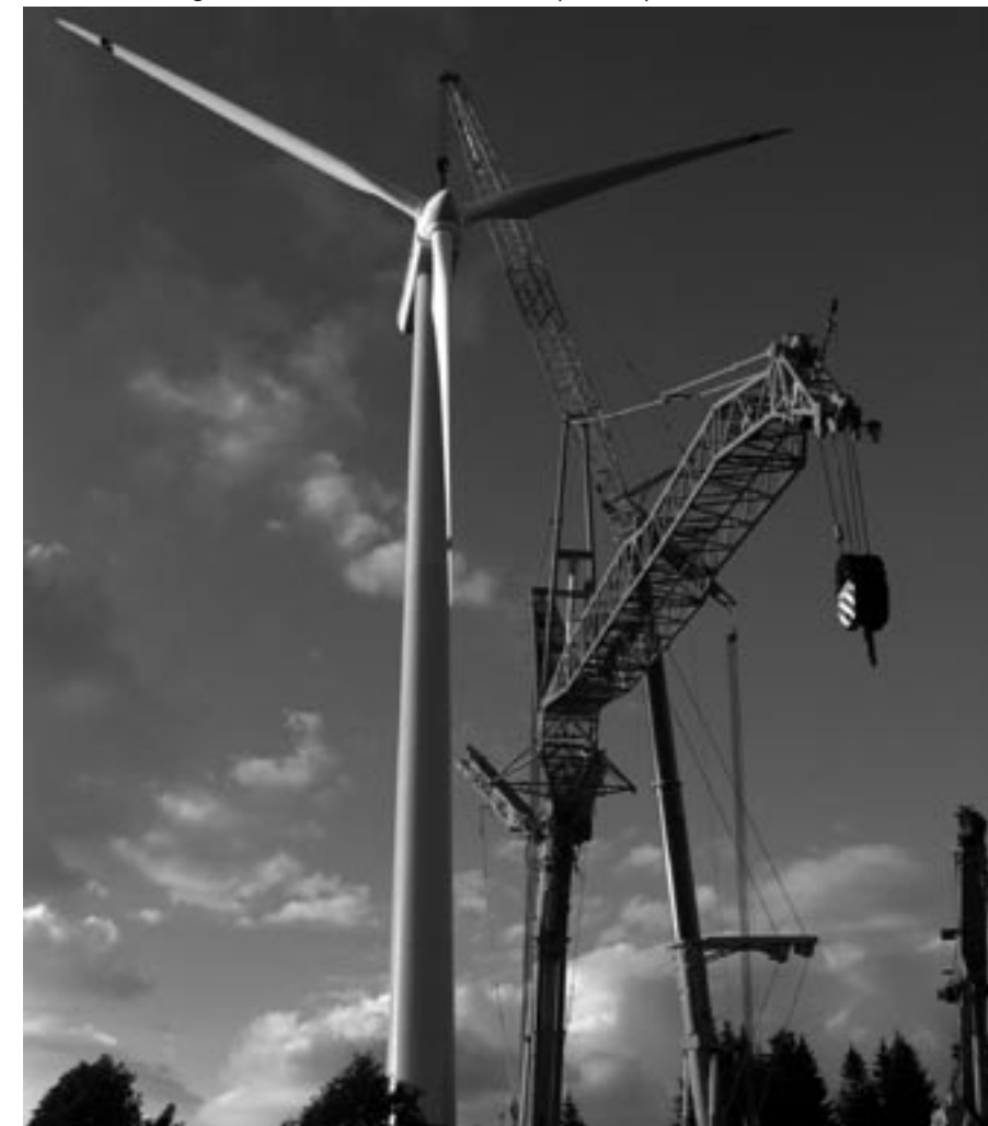
Juvent: Montage der Gondel und des Rotors (Bild: cr)
