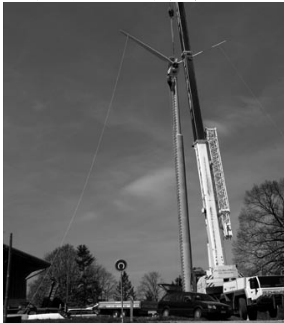
Jura-energie: Montage der Gondel mit 2 Flügeln (Bild: cr)
